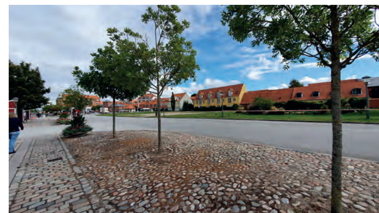
Facaderne ud mod Yderhavnen. Facaderne danner væg for havneområdet og ses tydeligt fordi området foran er holdt fri for beplantning og bygninger.
