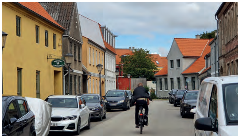
Strandgade set fra syd. Blandingen af pakhuse, etageejendomme og gårde vidner om gadens ændrede funktioner op gennem tiden. Det gråpudsede hus med gavlkvisten ligger netop hvor gaden knækker og dominerede derfor indtrykket af gaden. Knækket 'lukker' også gaderummet så det føles mere beskyttet.
