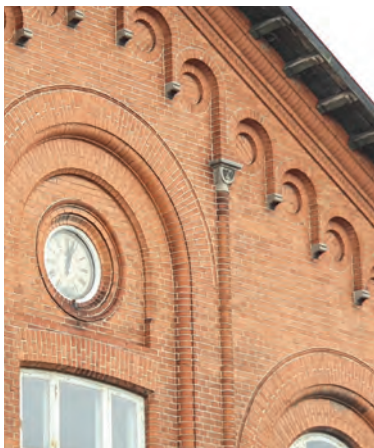
Ur og murværksdetaljer på den gamle stationshovedbygning.
