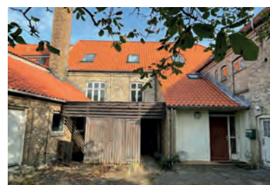
Købstadshusene har typisk flere små tilbygning på gårdsiden, som er bygget til efter behov.
