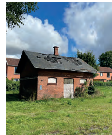
Frysehuset er én af stationsområdets oversete bygninger.
